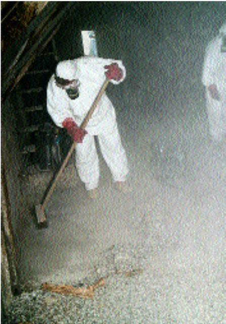
**Abb. 3:** Reinigungstätigkeit auf einem mit Taubenkot verunreinigten Dachboden. Beim Fegen des getrockneten Kots entstehen erhebliche Staubmengen. Die Arbeitnehmer sind mit Einmalschutzanzügen, Sicherheitsstiefeln, wasserundurchlässigen Handschuhen sowie Atem- und Augenschutz ausgestattet.
